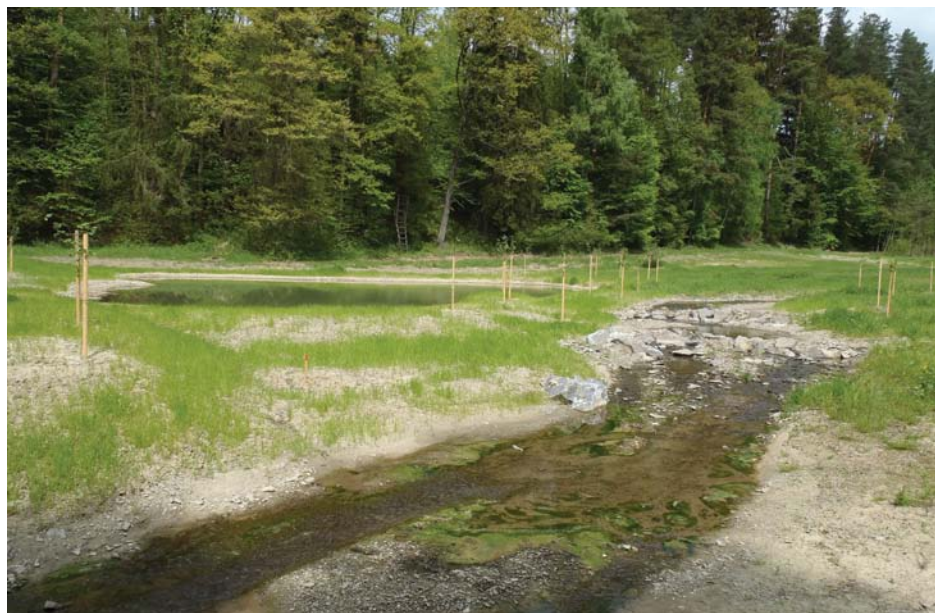
Boční tůň a zemní val k podpoře rozlivů
