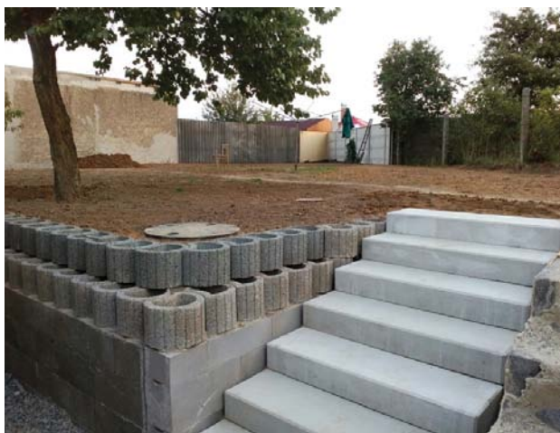
Pozemek po realizacji
