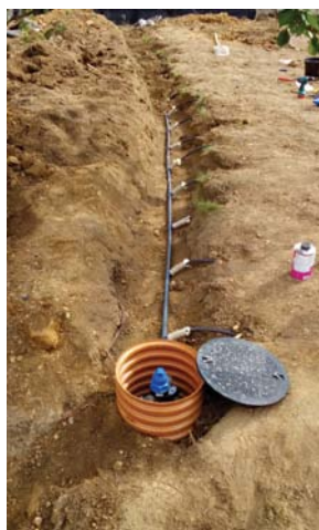
Napojení kapkovacích hadic
